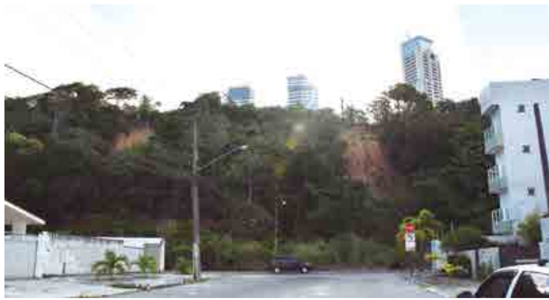
Deslizamentos ocorreram há dois anos no Cabo Branco, deixando trecho da barreira sem cobertura da vegetação
